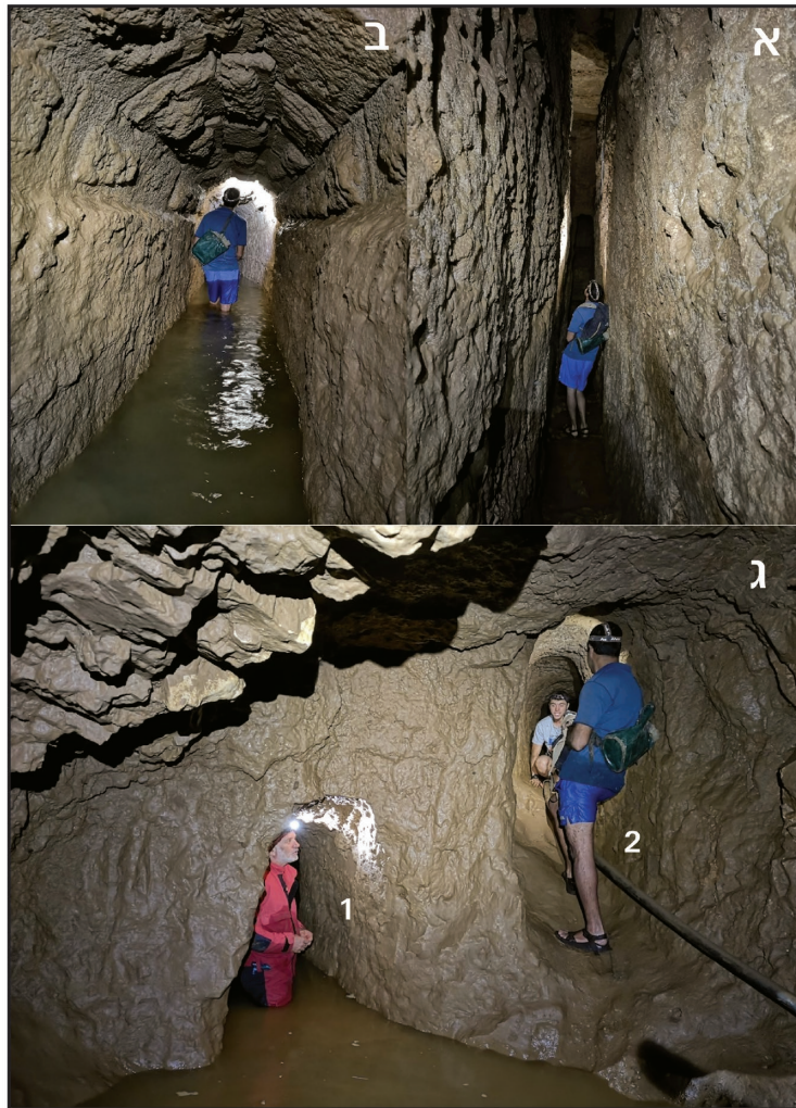
איור 3. מנהרת הפירים, מתחילתה עד פיר 1: (א) מנהרה חצובה בגובה 5 מ', מקורה בלוחות אבן (ראו איור 2:א, חתך 3); (ב) מנהרה חצובה מקורה בקמרן חבית בסיתות שוליים גס (ראו איור 2:א, חתך 9); (ג) מפלס המנהרה הנוטשה (2) אל מול מפלס המנהרה הראשית (1), סמוך לפיר 1 (צילום: י' נגב).
