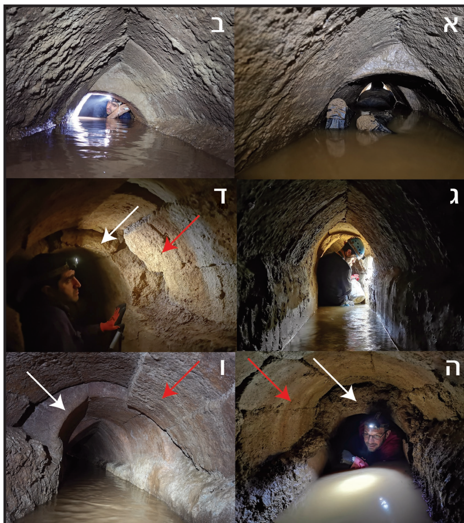
איור 12. האמה שנבנתה בתוך מנהרה חצובה, בין פיר 20 לפיר 22: (א-ג) מעברים תכופים בין גמלון קמור לקמרון חבית — שימו לב לחיבור המדוקדק בין שתי שיטות קירוי אלו המעיד שהם נבנו כיחידה אחת; (ד-ו) קמרונות חבית בנויים מחמישה נדבכים (חיצים אדומים), גבוהים ורחבים מ־specus יתר האמה — שימו לב לחוסר ההתאמה בין קמרונות אלו לקמרונות שלושת הנדבכים (חיצים לבנים), עדות לכך שהפירים בוטלו זמן־מה לאחר הקמת המערכת (צילום: י' נגב וע' יחזקאל).
